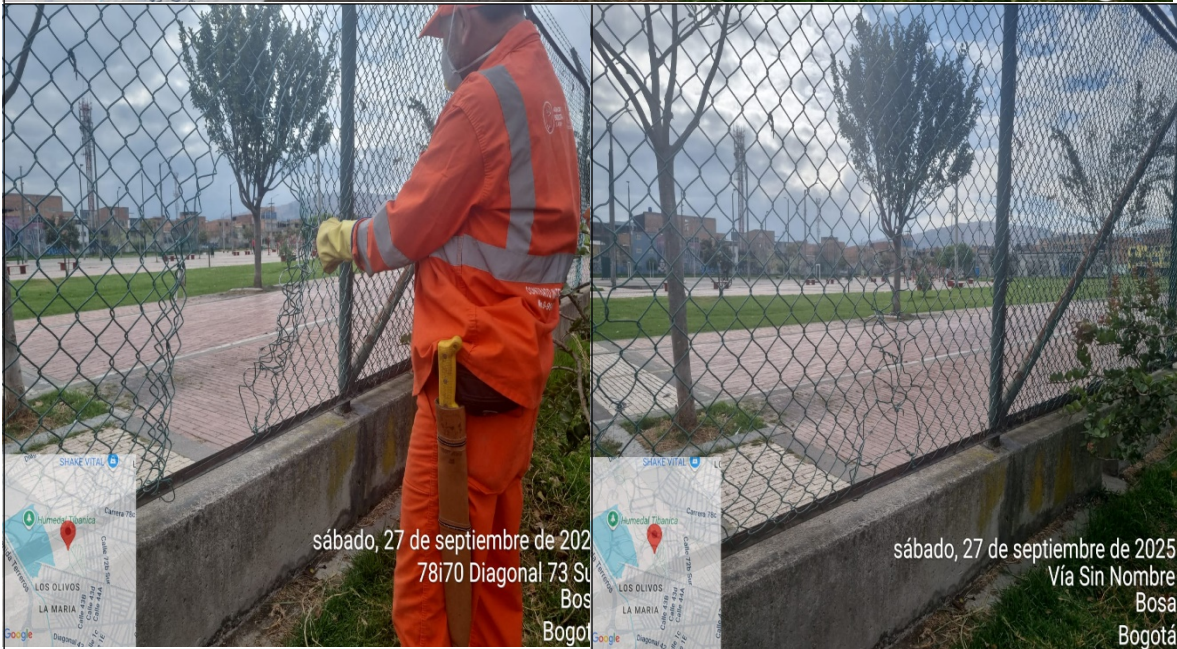
Imagen. Soporte fotográfico de la reparación realizada
